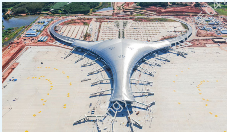
作为广东机场集团贯彻落实省委、省政府“1+1+9”工作部署，构建“一核一带一区”区域发展新格局，促进全省区域协调发展的一项重要措施，也是推进全省“5+4”骨干机场布局建设的重要工程项目之一，中建安装南方分公司参建的广东湛江吴川国际机场定位为国内干线机场。投运后，将辐射粤西及北部湾等地，加快航空物流发展，加快粤西融入世界的步伐！
