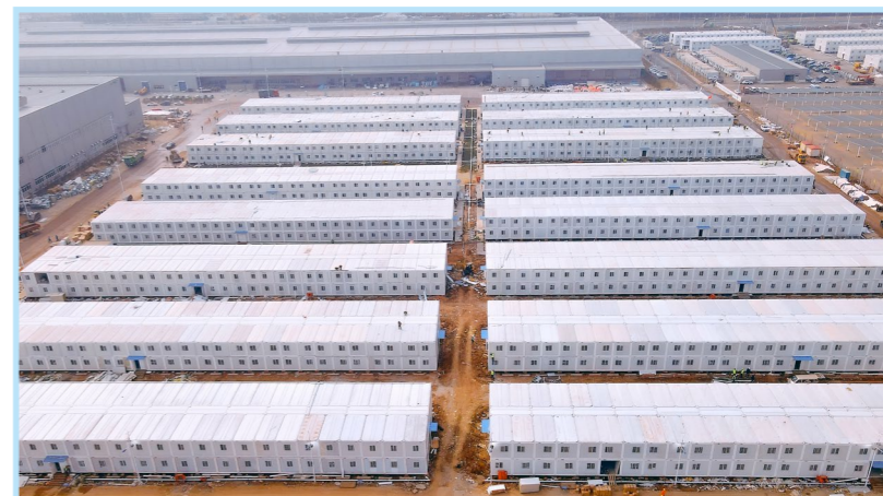
青岛莱西市姜山方舱医院及应急隔离场所项目
