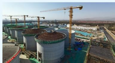
近日,华北公司承建的中央储备粮秦皇岛直属库海港粮食储备基地项目三期MEC工程正式开工。该工程作为秦皇岛市重点民生项目,是打造千亿级粮油食品加工产业园区的重点工程,共建设浅圆仓30座,总仓容24万吨,华北公司承建简仓及提升塔输送工艺设备、空压系统、粉尘控制系统等MEC工程。项目建成后将有效打通粮食储备和加工上下游环节,助推临港产业结构调整,对服务国家粮食宏观调控、保障京津冀粮食供应具有重要意义。
