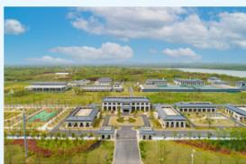
作为合肥市首个标准化样板水厂，项目首次采用前置式上流深度处理的制水工艺，建设规模20万立方米/天，满足肥西县及合肥经开区、滨湖区区域经济发展用水需求，进一步优化全市水厂布局及供水调配调度。
